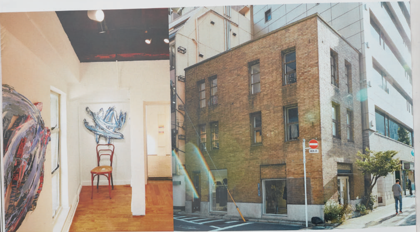
スクラッチタイルの一種、加飾タイル外壁が印象的な外観。昭和通りに面した一部は、1934(昭和9)年頃に増築した模様。設計者は不明。撮影=深水敬介
