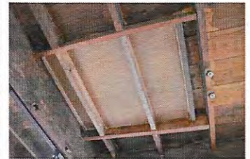
穴の痕跡がある木造の床面
